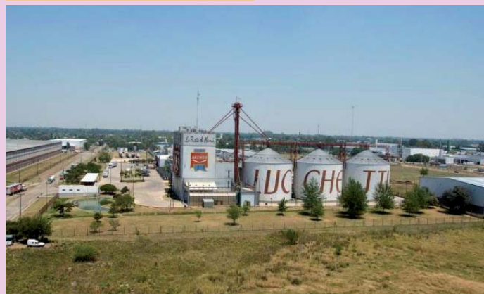
PANORÁMICA DE LA PLANTA
