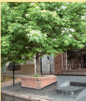
Planteras pequeñas e inadecuadas
